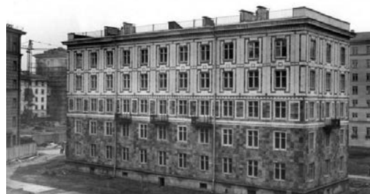
Рис. 18. Первый бескаркасный крупнопанельный дом, построенный в Ленинграде на ул. Полярников, д. 10 в 1955 году трестом № 3. Архитектор А. В. Васильев, инженер З. В. Каплунов
